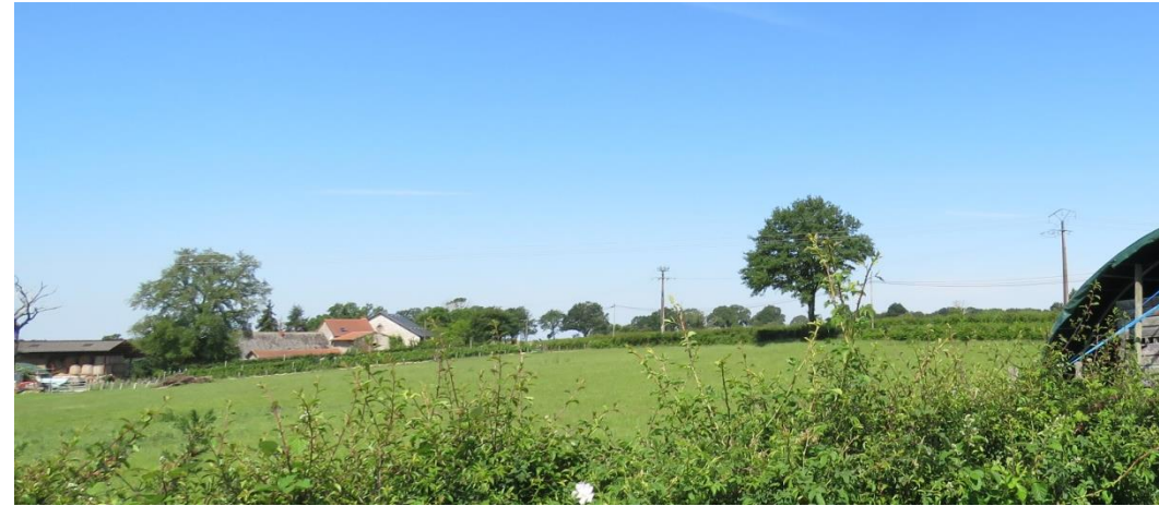
Ligne à Haute Tension traversant les terrains étudiés
