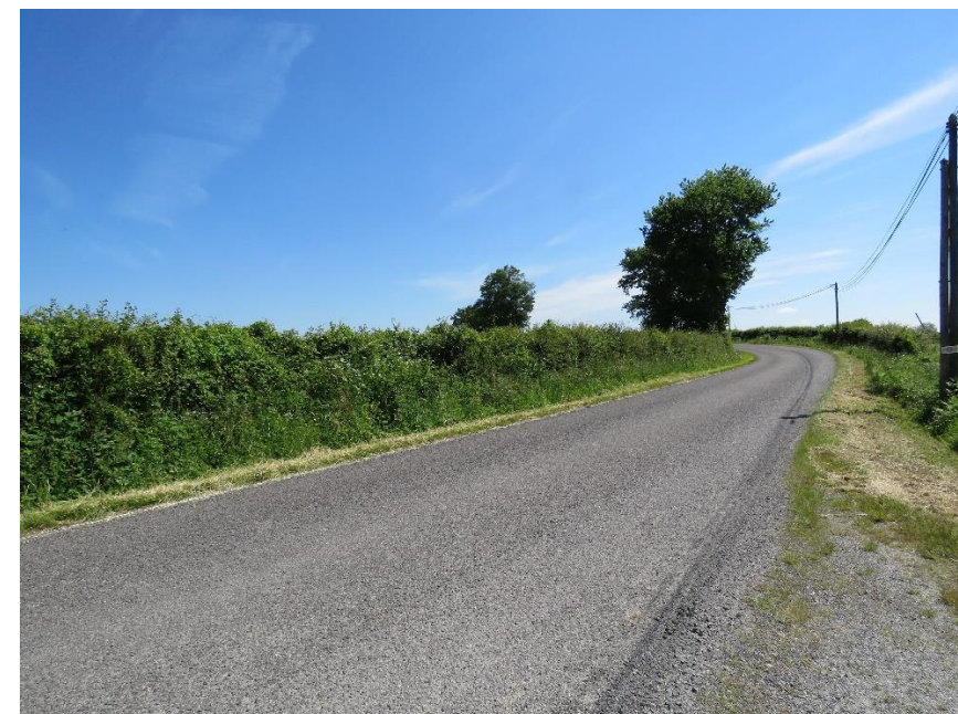
La RD 44A2 au niveau des terrains étudiés
